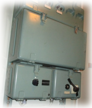
Kuvat 20–23. Oikeanpuoleisen oven takana sähköpääkeskus, siellä myös veden pääsulkeminen. Oveen laitetaan puuttuvat tarrat sähköpääkeskuksesta ja käyttöveden pääsulkemisesta.
