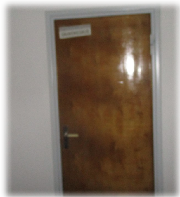
Kuva 8. Sähköpääkeskus kirkonpääovien eteistilassa
