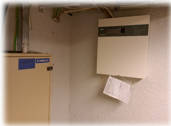
Kuva 6. Turvavalokeskus kellaritilassa
