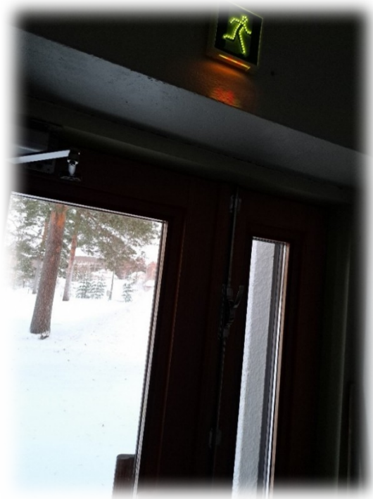
Kuva7. Turvaopaste kirkon pohjoispuolen sisäänkäynnissä
