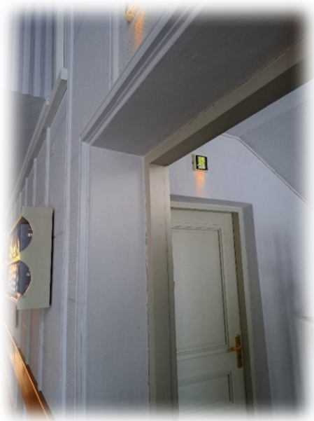
Kuva 15. Turvaopaste kirkosta pääovelle pääsisäänkäynnille
